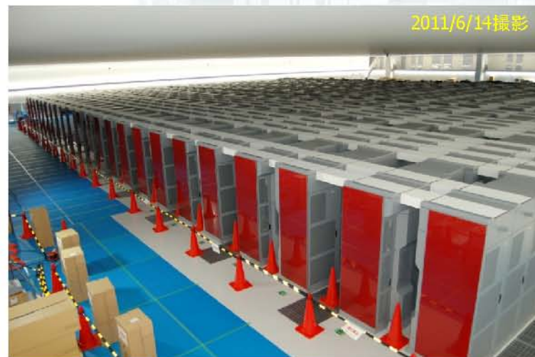
システム設置状況
